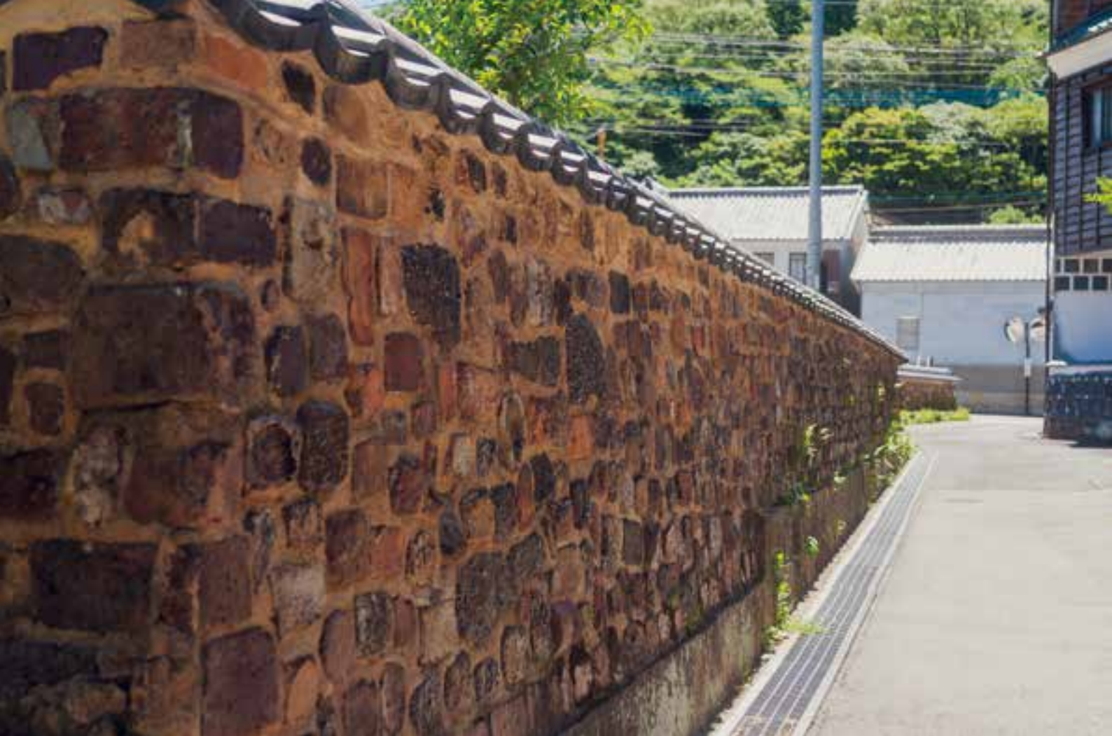
トンバイ塀。登り窯を築くために用いた耐火レンガ（トンバイ）の廃材や使い捨ての窯道具を赤土で塗り固め作った塀である。
